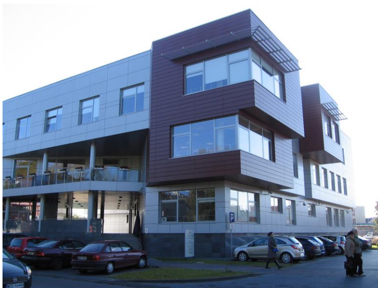
Fot. 44 : 2012 – budynek UM przy ul. Piłsudskiego 38. Parter i I piętro w widocznej części budynku zajmuje BP. Źródło: dokumentacja cyfrowa BP.
